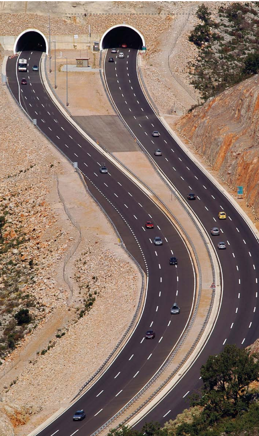
Tunel Mala Kapela
